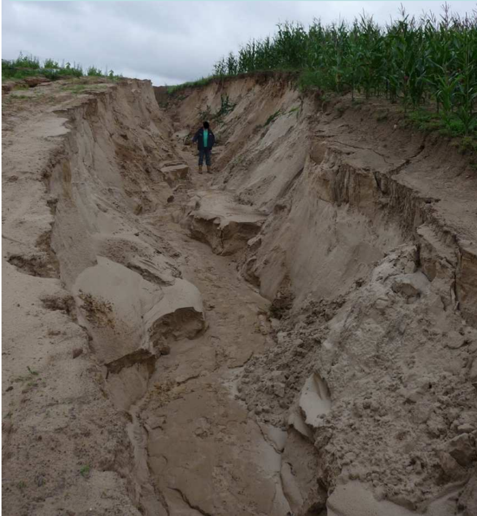
Erosionsgraben auf einer Baustraße © Ingenieurbüro Feldwisch
