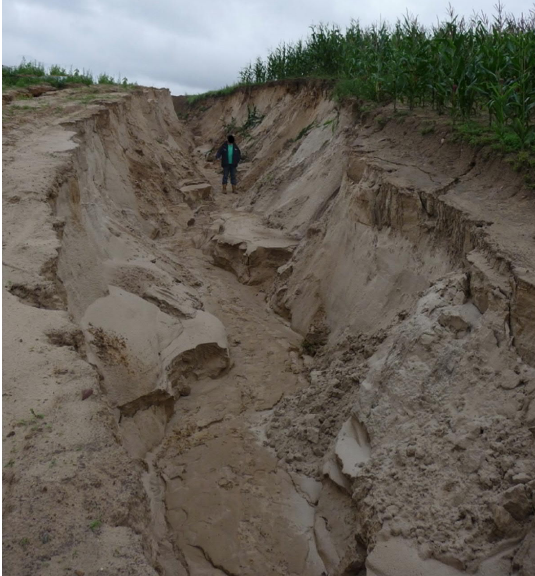
Erosionsgraben auf einer Baustraße © Ingenieurbüro Feldwisch
