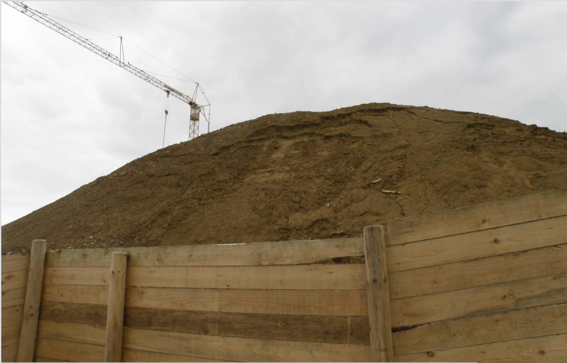
Brückenkopf nach Mutterbodenanddeckung, erste Rutschungen
