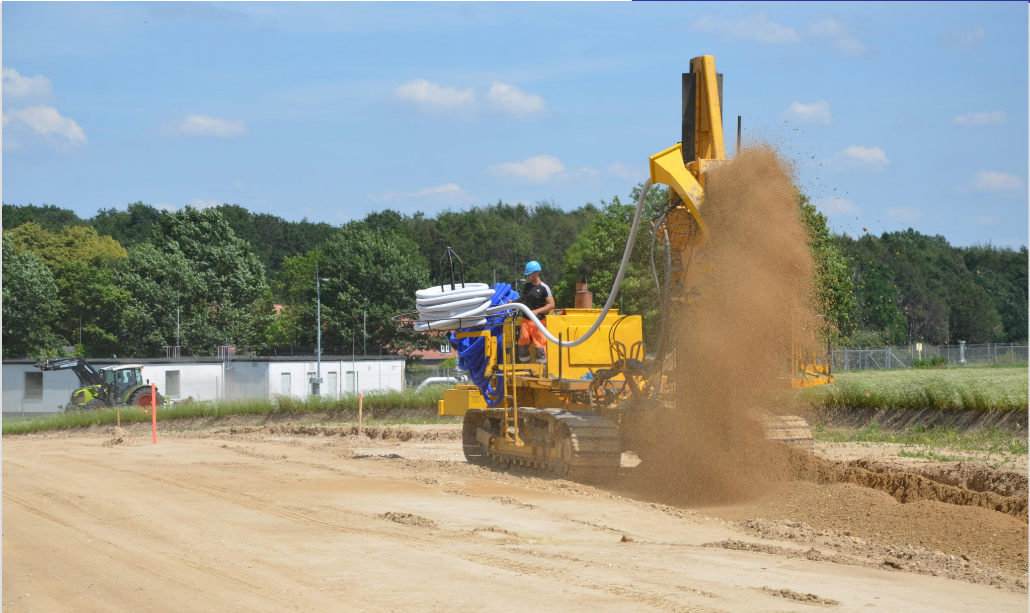
Dränfräse im Einsatz → Mischboden im Fräsgang
