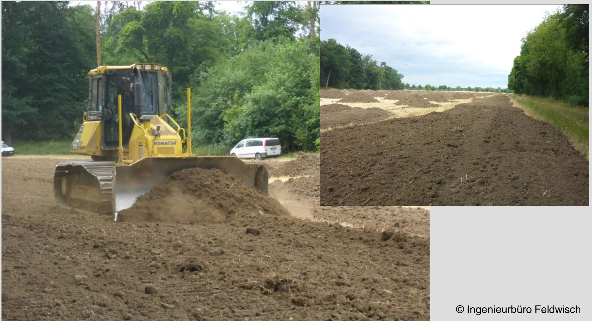
Verteilen des Oberbodens mit Planierraupen.
