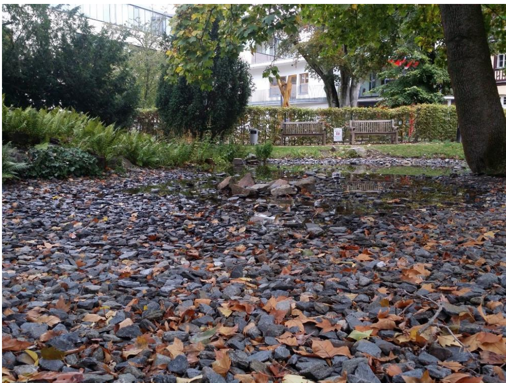
Abbildung 1: Versickerungsbecken; Quelle: StadtLand
