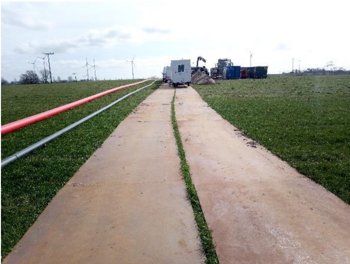
Abbildung 13: Schutz des Boden vor Verdichtung bei einer Baumaßnahme – „Baustraße“. Jenaer GEOS K. Roselt 2022
