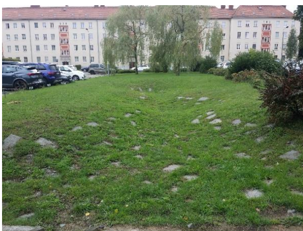
Abbildung 9: Muldenversickerung im Dunkerviertel in Leipzig. Eigene Aufnahme 2022
