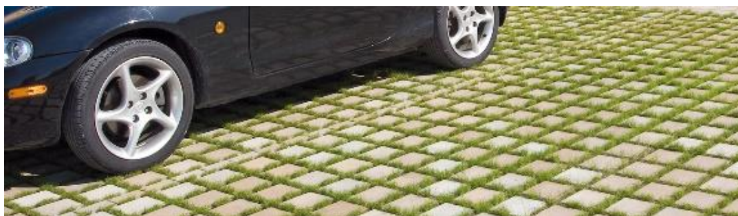
Abbildung 5: Parkplatz mit vergrößerten Fugenräumen, Quelle: Bernhard Hartmann GmbH 2022
