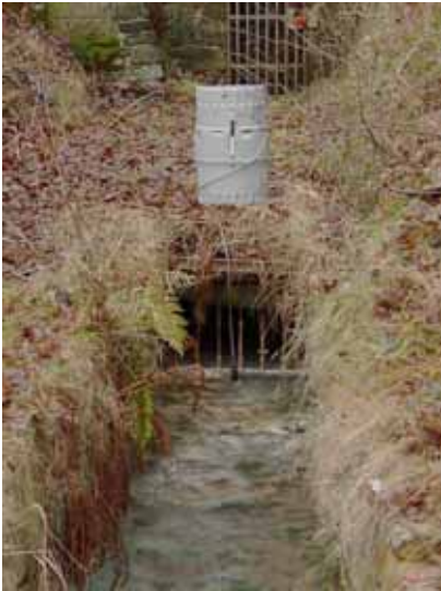
Abbildung 17: Probenahmegerät am Mundloch des KVGS
