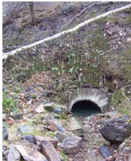
Abbildung 4: Mundloch der Hüttenrösche Muldenhütten (linksufrig unterhalb des Hüttenkomplexes Muldenhütten); überkippt von der Hausmülldeponie
