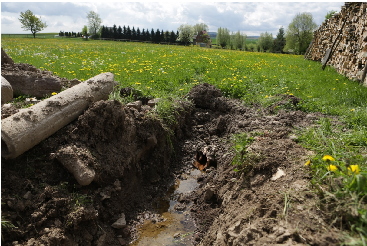
- Entwässerung einer Nasswiese (Quelle: Fotoarchiv LfULG)
