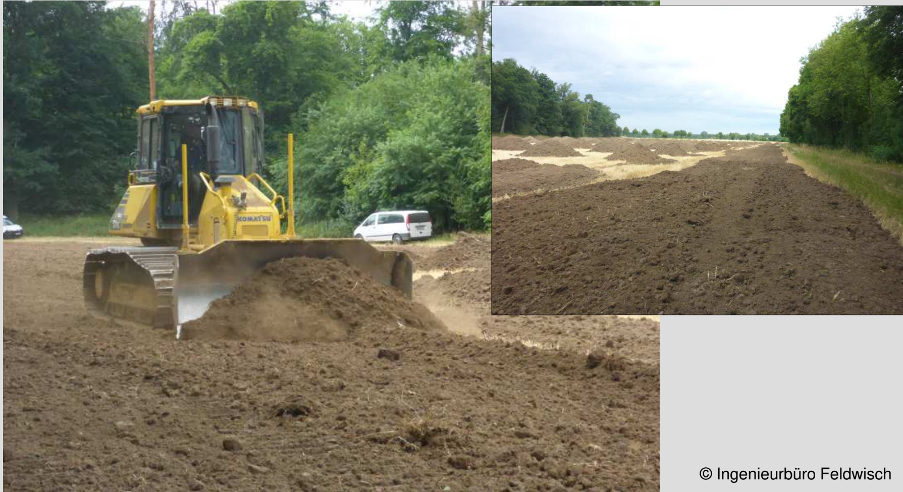
Verteilen des Oberbodens mit Planiertrauben.
